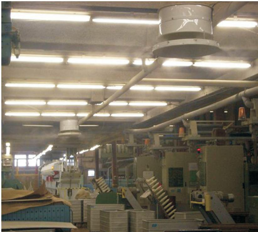
Los sistemas de refrigeración PrimeTech permiten mantener la temperatura y humedad ambiental dentro del rango de confort adecuado a cada tipo de actividad.
